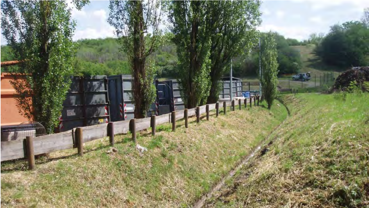
Versickerungsgraben auf der nördlichen Seite des Wertstoffhofs kurz nach Durchführung der Pflegemaßnahmen (Mai 2020)
