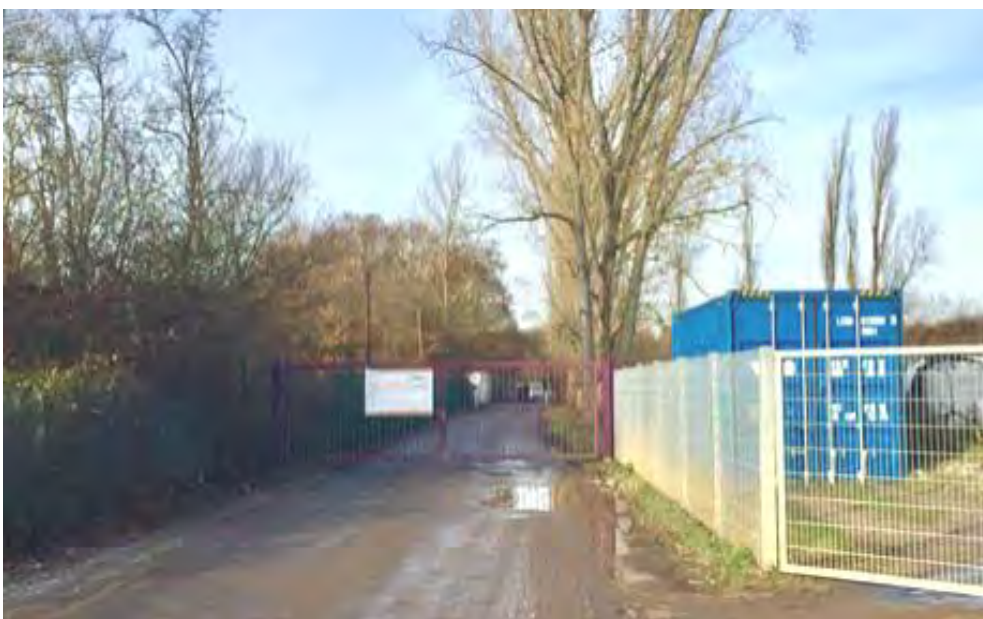
Abbildung 7 Zufahrtsstraße mit Toranlage zur Kompostieranlage mit Kleinmüllsammelstelle (Quelle: Aufnahme Stadt Viernheim)
