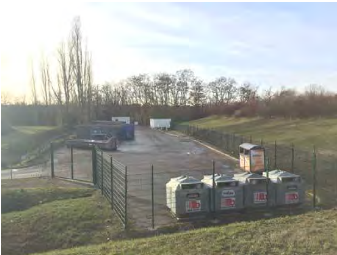
Abbildung 9 Südöstlicher Bereich des Wertstoffhofes (Quelle: Aufnahme Stadt Viernheim)
