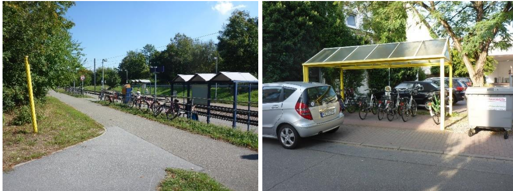
Abbildung 13: fehlende/ unzureichende Radabstellanlagen
