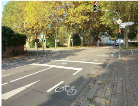
Führung an Knotenpunkten und Einmündungen
