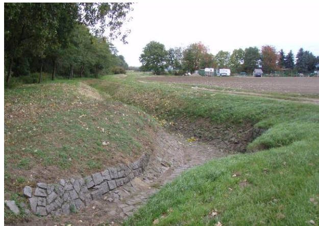
Abb. 26 Mündung des Ausflussgrabens der Kläranlage in den Bannholzgraben
