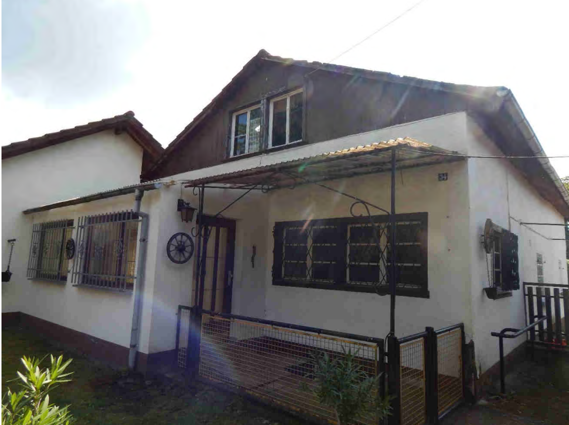
Abb.5: Ansichten des Anwesens „Tante Anna“ Flurstücke 75/67 bestehend aus drei Gebäudekomplexen unterschiedlichen Datums, die der Eigentümer abreißen möchte. Oben, die ehemalige Wirtschaft mit dem alten Wohnhaus. Unten, das alte Wohnhaus mit neuem Anbau.
