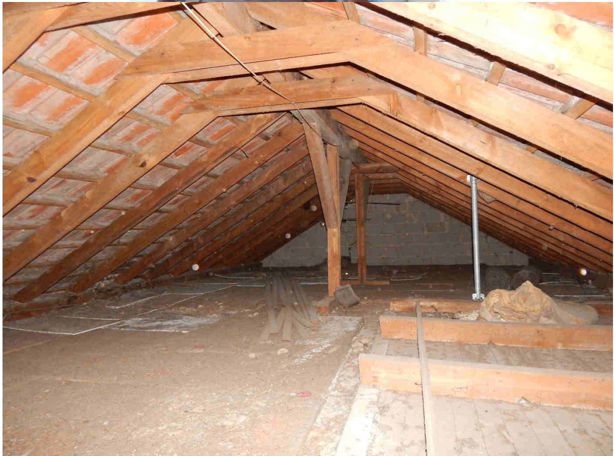
Abb. 8: Oben, Blick in den Dachstuhl des alten Wohnhauses und unten des neueren Anbaus.
